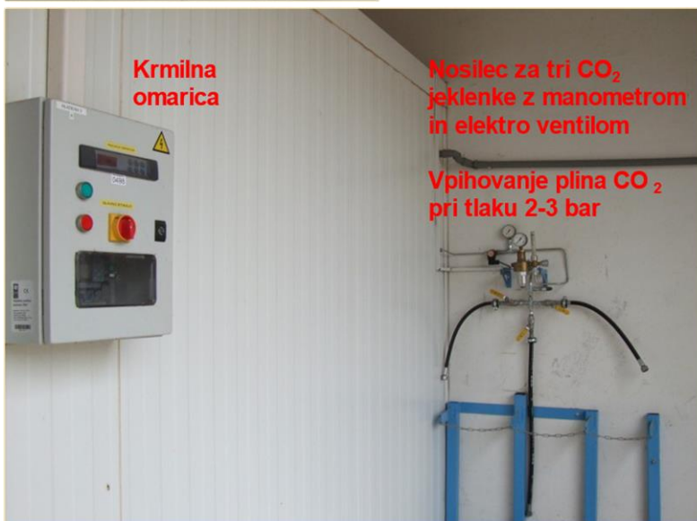
Slika 3: Zunanost plinotesne komore za zorenje plodov kakija s plinom CO 2 v SC Bilje
